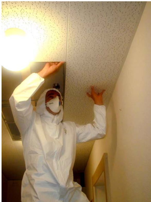
Faux plafond, photo: JMF/SLE, IST
