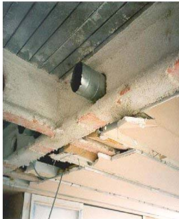
Flochage d'une structure métallique, photo: JMF/SLE, IST
