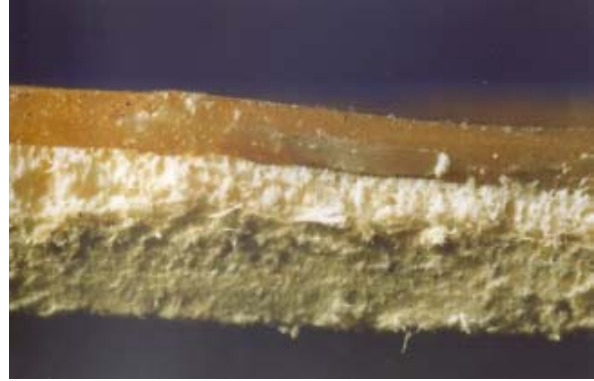
Coupe transversale d'un revêtement de sol à trois couches dont la couche inférieure est composée d'un carton d'amiante, photo: SA
