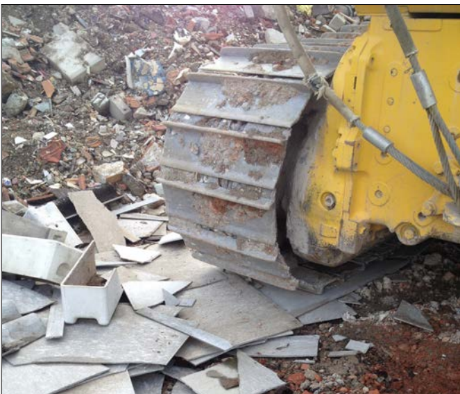
Broyage au trax de bacs et plaques d'Eternit sur la décharge de Chavannes-sur-Moudon en 2015. Photo: Philippe Pichon
