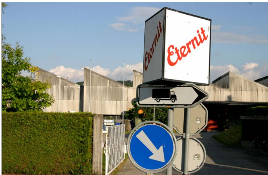
L'usine Eternit de Payerne – toujours recouverte d'amiante-ciment – construite en 1957 à 40 km de Lausanne.
