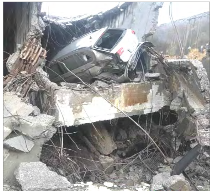
Les traînées rougeâtres témoignent de la corrosion des armatures du béton.
